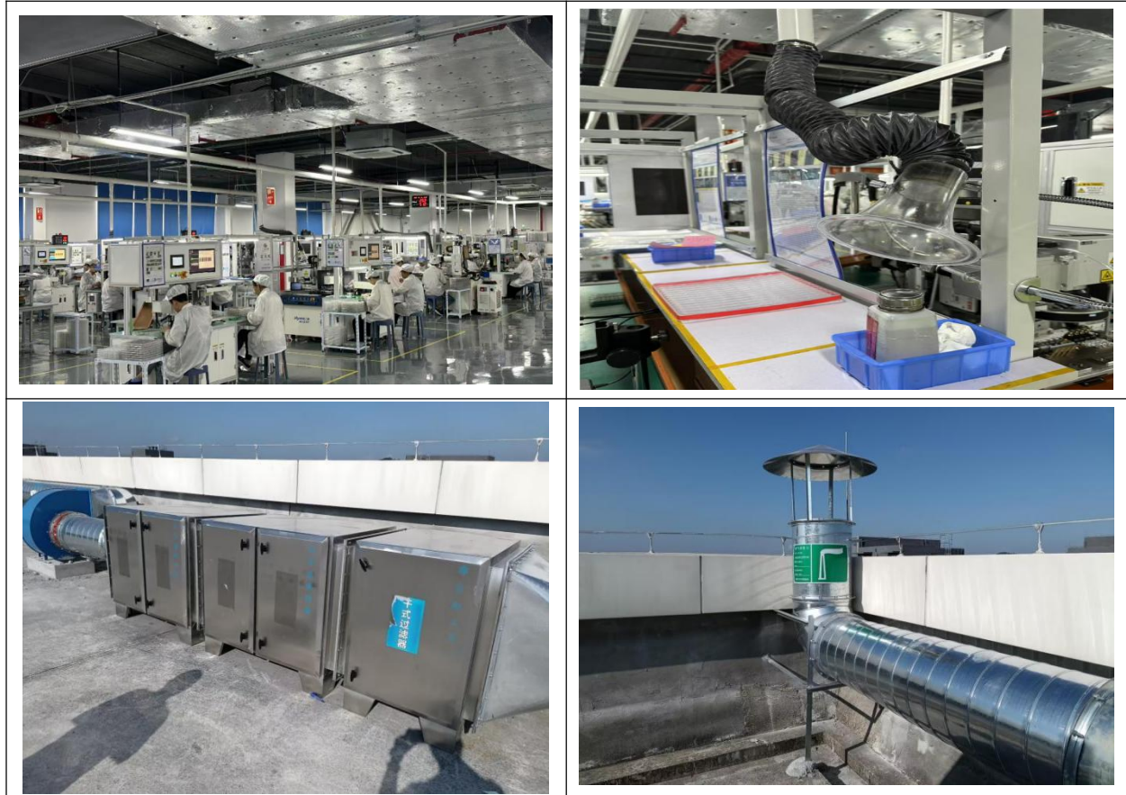
图4.2-1废气收集及治理设施现场图片
